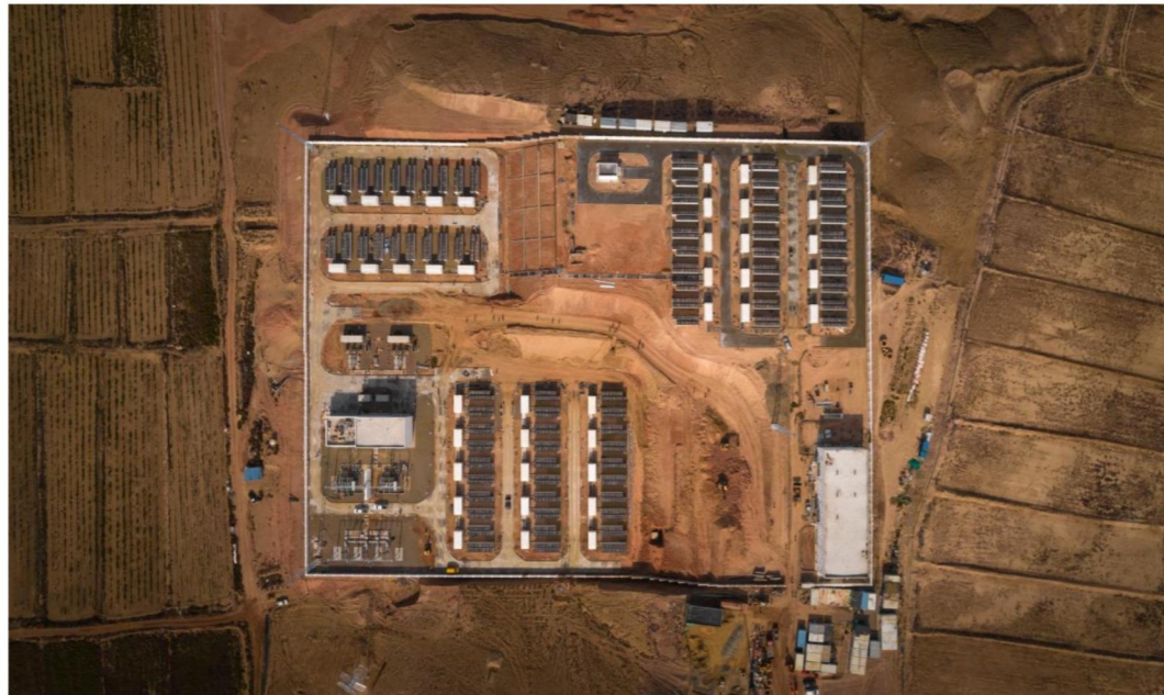
宁夏华严200MW/400MWh储能电站
